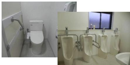
〇アイリストイレ改修工事 令和4年10月に老朽化のため、男性用・女性用のトイレと洗面所の改修工事を行いました。トイレは床の張替や便器の交換・消毒クリーナーを設置、衛生面を整えました。てすりの補強も行い、安全面にも配慮しています。洗面所は、洗面台交換とお湯がすぐに出るシステムを取付、寒くても手洗いがしっかりできるようにしました。
